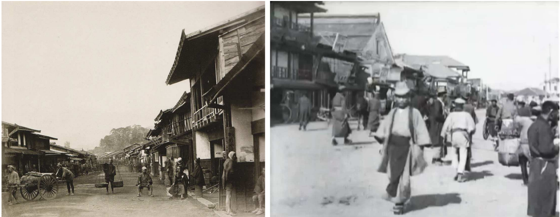
Figg. 9-10 A sinistra: una strada di Odawara in una fotografia di Beato [da C.G. Philipp, D. Siebert, R. Wick (a cura di), Felice Beato , cit., p. 95]. A destra: Une rue à Tokyo di Girel (Lumière n. 738, 9 gennaio 1897).
